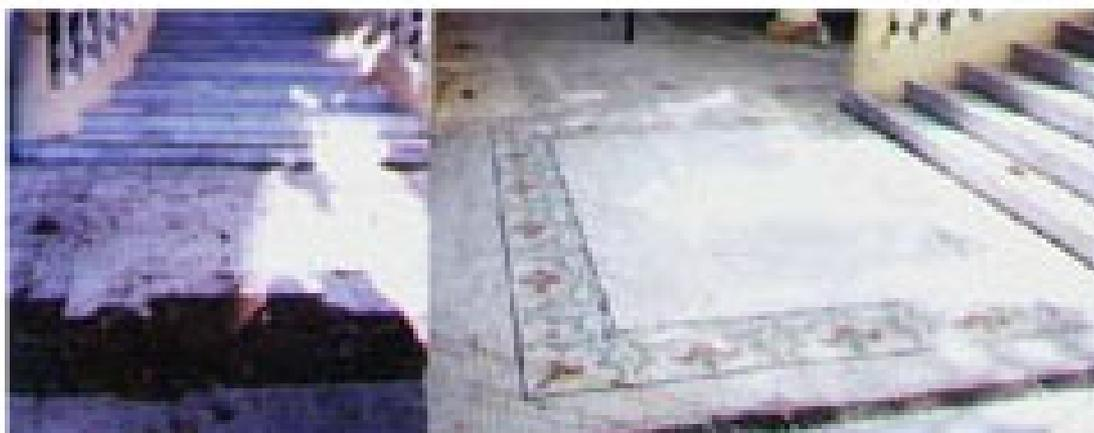
**Piso restaurado parcialmente na entrada da Escola, com motivos florais feitos através de um mosaico com uma grade de metal específica, com 145 posições de cores e uso de 7 cores diferentes, desenvolvidas á partir de peças existentes. Todo o piso da Escola em Ladrilho Hidráulico foi tratado com uma resina para protege-lo de agressões químicas e funcionar como enceramento definitivo.**
